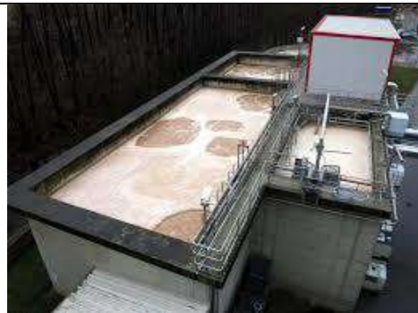
Planta de Tratamiento de Efluentes Industriales: Respetuosa posee una planta de tratamiento de sus efluentes líquidos donde se eliminan de su peligrosidad, evitando así la contaminación de cuerpos de agua y suelos.
